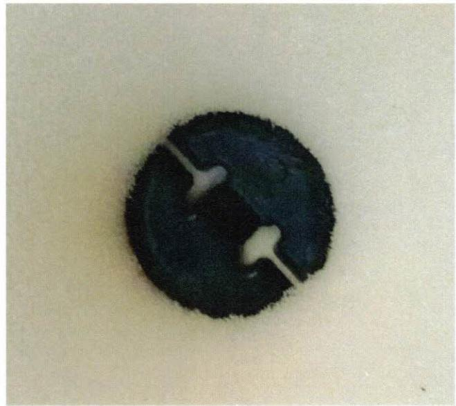
**2.** Na pěnovém podkladu je napínací lanko připevněno plastovým kolečkem.
